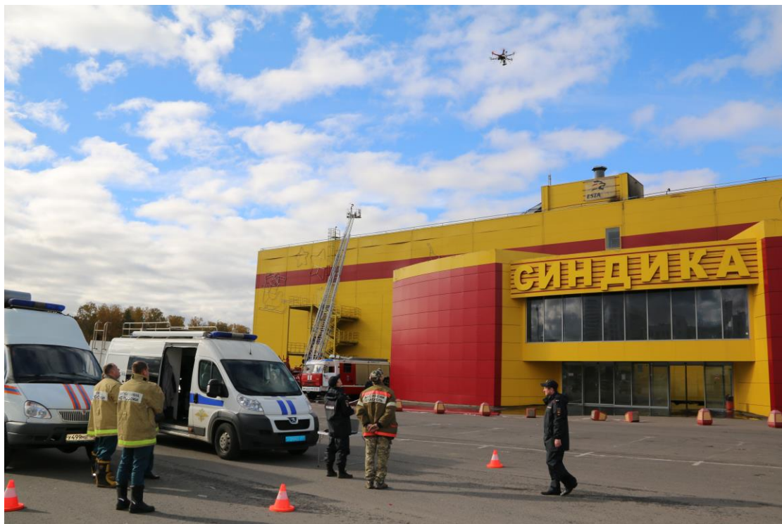
Рис. 3. Эксперты ЭКЦ МВД России проводят осмотр сгоревшего здания торгового центра с помощью БВС
