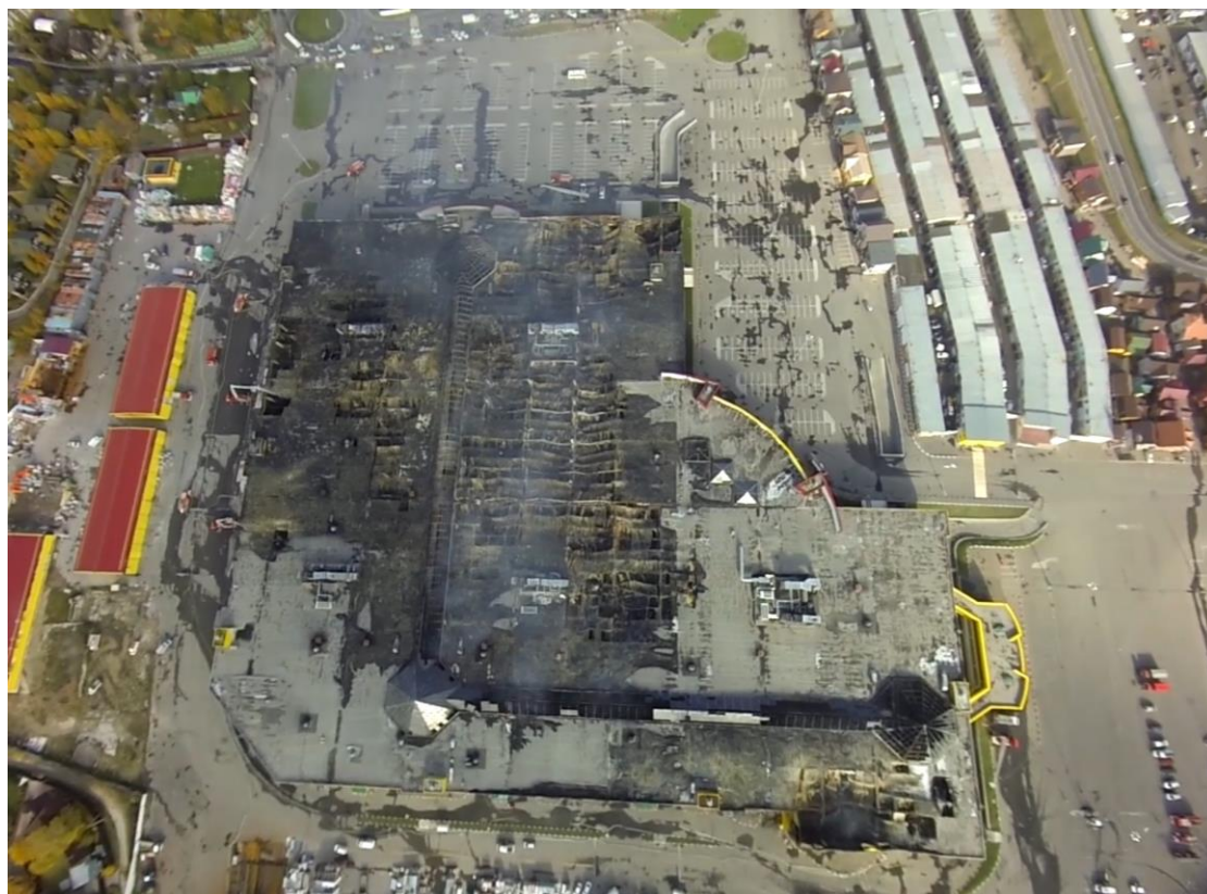
Рис. 4. Общий вид сгоревшего здания торгового центра, полученный с помощью БВС
