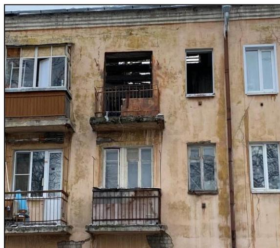
Рисунок 1. Повреждения дома в результате взрыва ТВС
